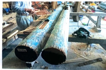
【既存木材保管場所 木材補修】 できる限り既存の木材を再使用し、当初の建物の姿を復元できるよう取り組んでいます。
