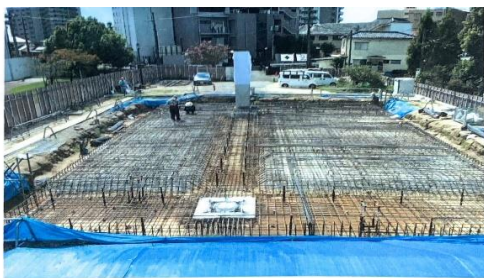
【移転先 全景】 マットスラブ(基礎部分)配筋中です。
